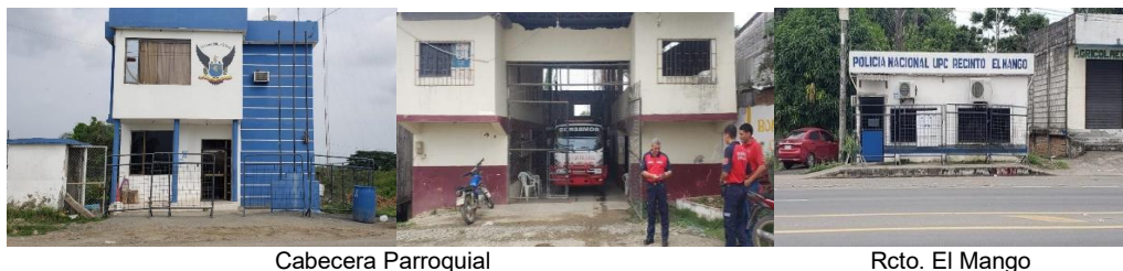
Fotos 5 Establecimientos de Seguridad e Incendios Parroquia Rural Taura
